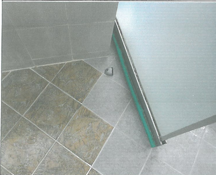
수영장 여자.남자.샤워실 출입문 편도 열림차단 장치 설치
