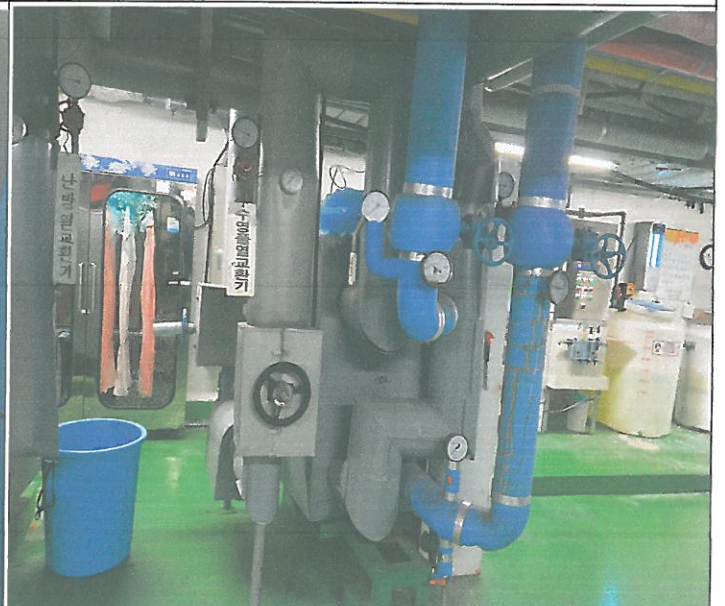
수영장 열교환기 차압밸브 차단 앵글밸브 스프링들 누수 볼트 전기용접수리
