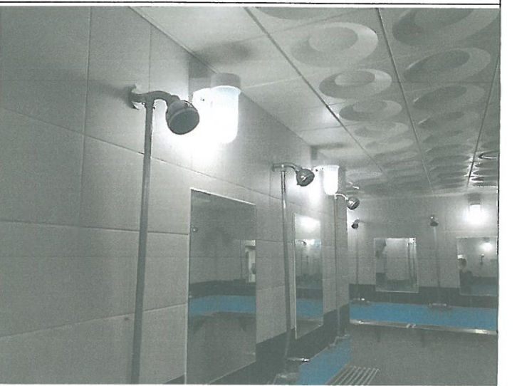
수영장 남자 샤워장 내 벽 전구 2개소 교체
