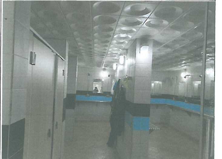
수영장 남자 샤워실 전등 교체
