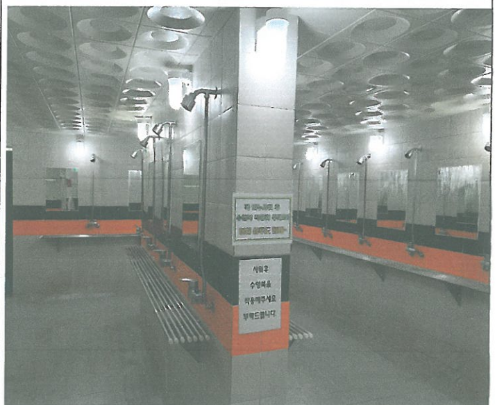
수영장 여자 샤워장 내 전구 3개소 교체
