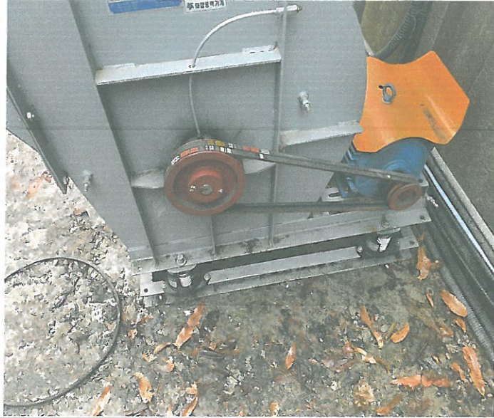
수영장 남. 여 샤워장 배기팬 V벨트 손실되어 교체
