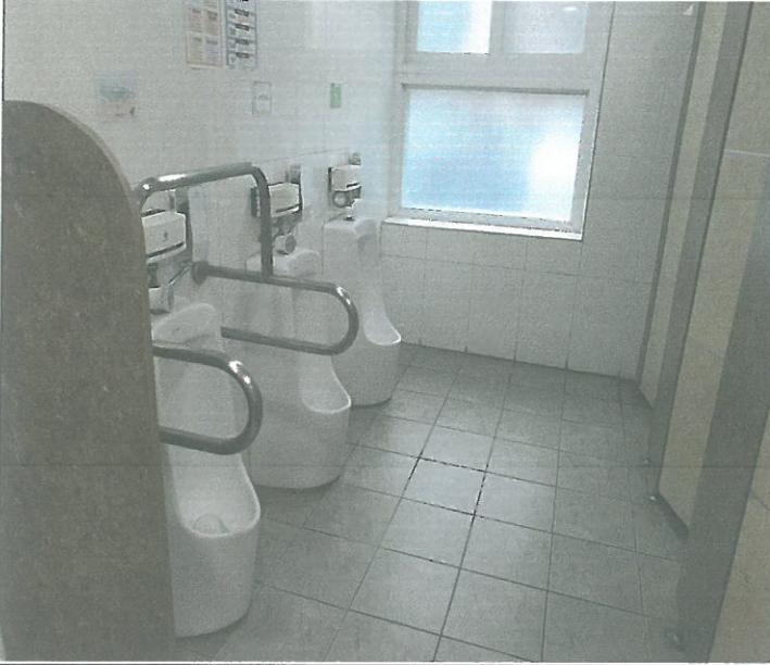
1층 남자 화장실 소변기 통수
