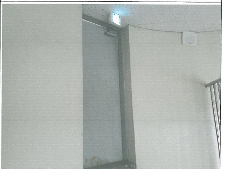
원형계단 옥상 출입방화문 단힘불량 교정 조치
