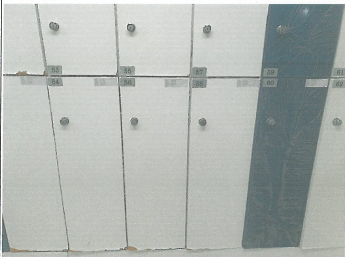
수영장 남자 탈의실 락카 열쇠 보수
