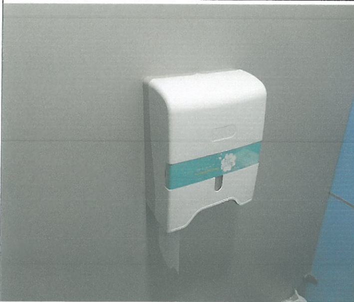
2층 3층 여자 여자 화장실 화장지 걸이 고장 수리
