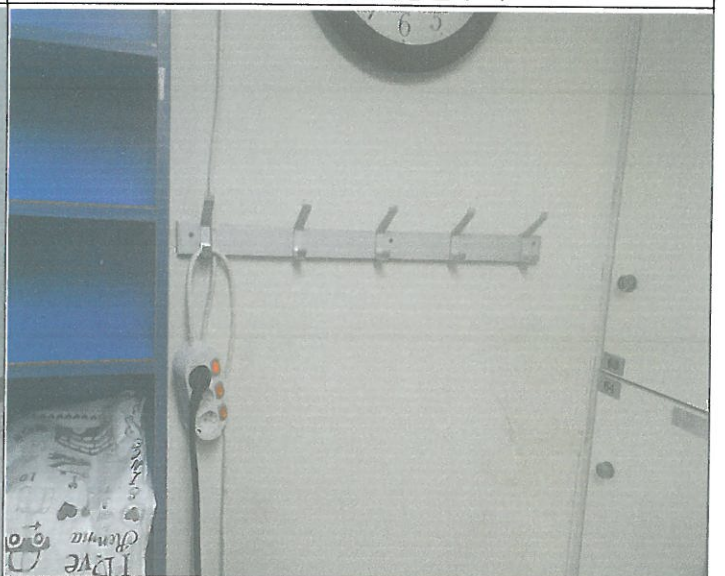
샤워실 내부 소지품걸이 탈락 부착
