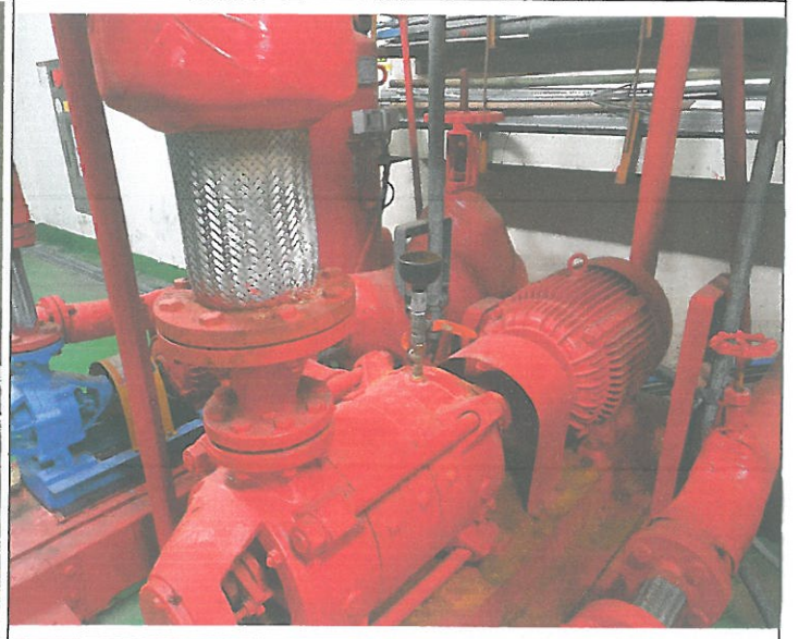
기계실 스프링클러 퍼프 에어밴드 밸브 누수 추가 밸브설치
