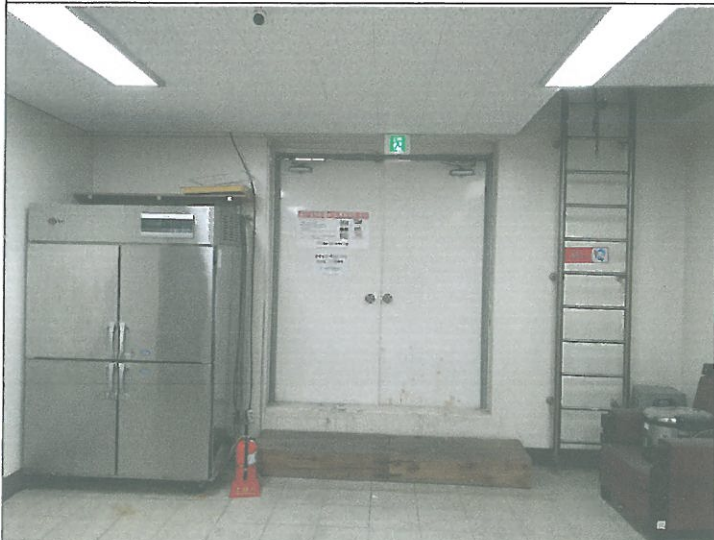
건물 옥상 출입 감종 방화문 편도 균형뒤틀림 단힘 불량 해체 교정후 재설치
