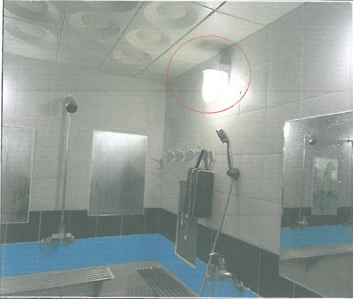
수영장 남자 샤워장 내 벽등 1개소 전구 교체
